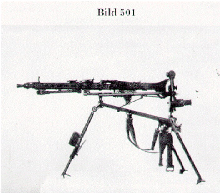
MG auf Feldlafette mit ausgeklappten Hinterstützen
